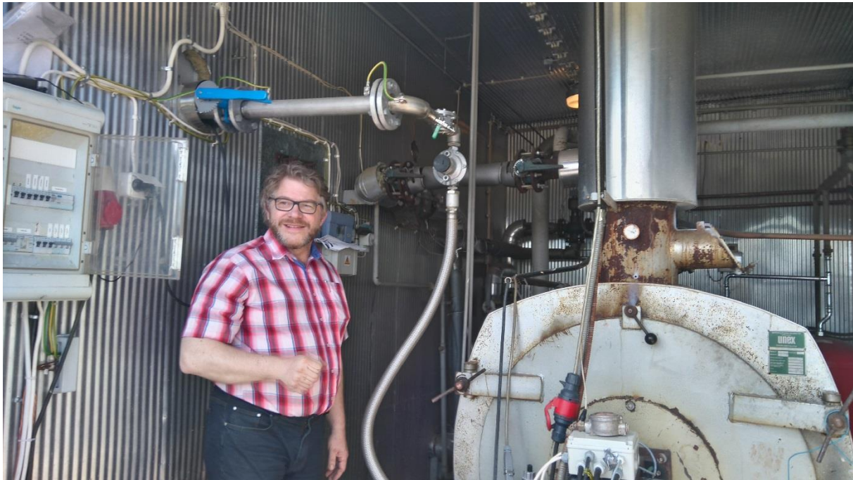
Kuva 2. Laitoksen omistaja Jarmo Ahola esittelee kaasukäyttöiseksi muutetun lämmityskattilan toimintaa.
